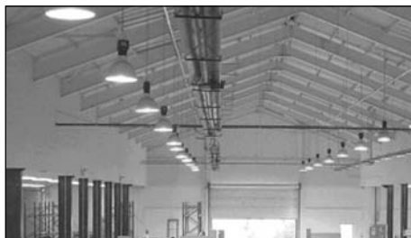
Рис. 3. Вариант способа замены ламп в цехе, где высота потолков 7 метров: спускающиеся светильники
